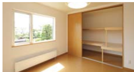
押入れの奥行きが深いので、奥まで手が届くように棚へこみを付けました。
