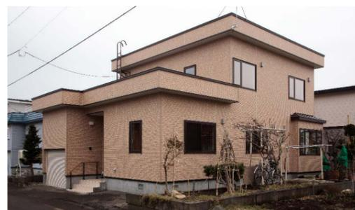
窓サッシもLow-Eのペアガラスに替え、断熱補強で暖かく
