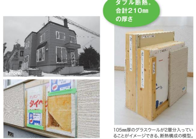
105mm厚のグラスウールが2層分入っていることがイメージできる、断熱構成の模型。
